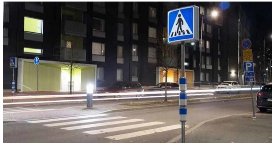
Пішохідний перехід з ліхтарем, оснащеним інтелектуальними датчиками, що виявляють пішохода, який наближається (Фінляндія)
