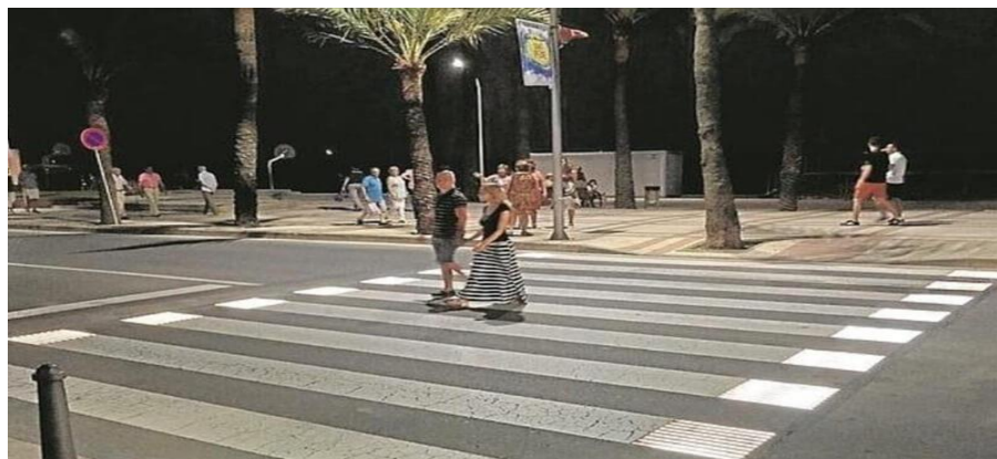
Пішохідний перехід з датчиками тиску, вмонтованими в «зебру», «впізнають» наближення людей, забезпечують вмикання світлодіодних ламп, розташованих на знаках та дорожній розмітці (Таррагона, Іспанія),
