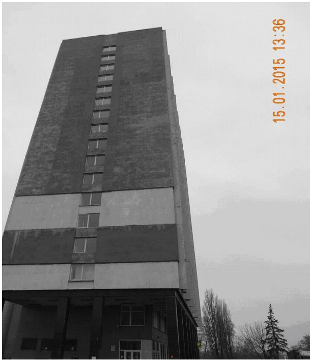
Рис. 13.11. Проведено утеплення східної торцевої стіни будівлі ІЛК підприємства
