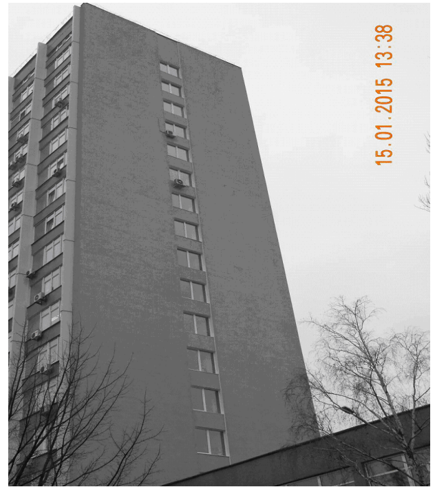
Рис. 13.12. Проведено утеплення західної торцевої стіни будівлі ІЛК підприємства
