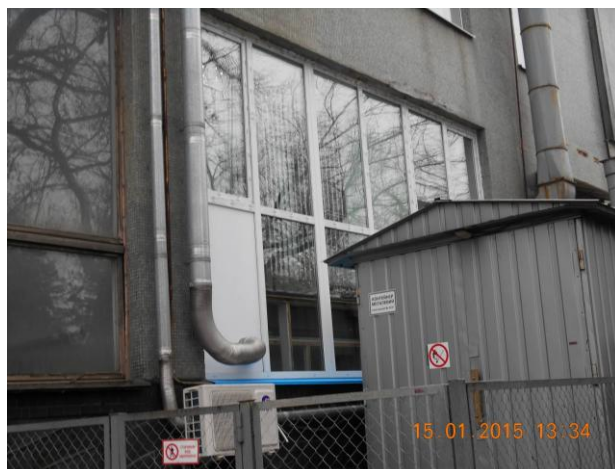
Рис. 13.8. Проведено заміну старих дерев'яних вікон на металопластикові енергозберігаючі в приміщеннях 1, 2 поверхів двоповерхової лабораторної прибудови (приміщення газоаналітичного комплексу та офісні приміщення персоналу випробувального центру)
