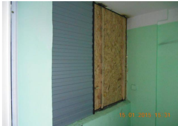
Рис. 13.6. Проведено ремонт, утеплення віконних проїомів допоміжних приміщень підприємства
