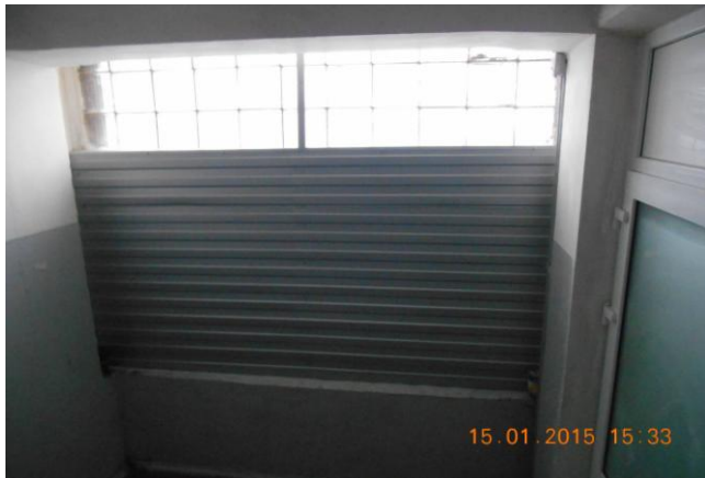
Рис. 13.5. Проведено ремонт, утеплення проїомів зашкленних склоблоками на еваковиходах та головної сходової клітини
