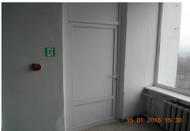
Рис. 13.3. Виконані роботи по ремонту, заміні, утепленню дверей в холах на поверхах ІЛК та евакуаційних виходах
